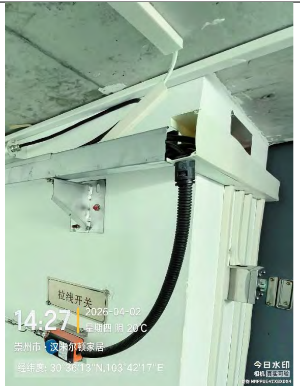
(b) 主机室拉线开关（部分）
