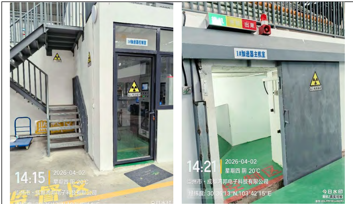
图 3-4-2 本项目 1#工业电子加速器机房当心电离辐射警示标志、工作状态指示灯及音响警示
