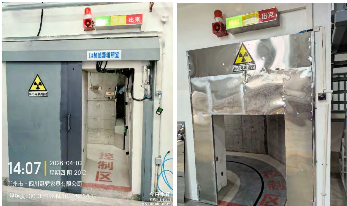
图 3-4-1 本项目 1#工业电子加速器机房当心电离辐射警示标志、工作状态指示灯及音响警示
