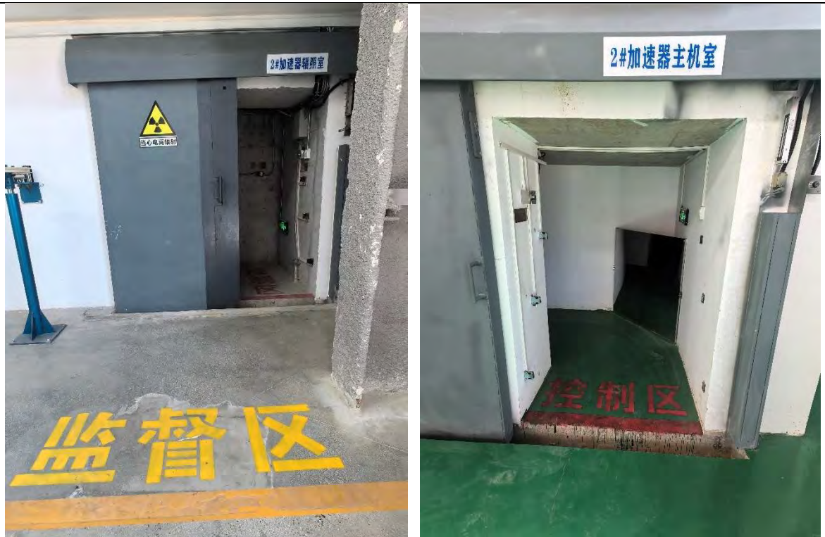
图 3-3 本项目 2#工业电子加速器机房辐射防护分区现场照片
