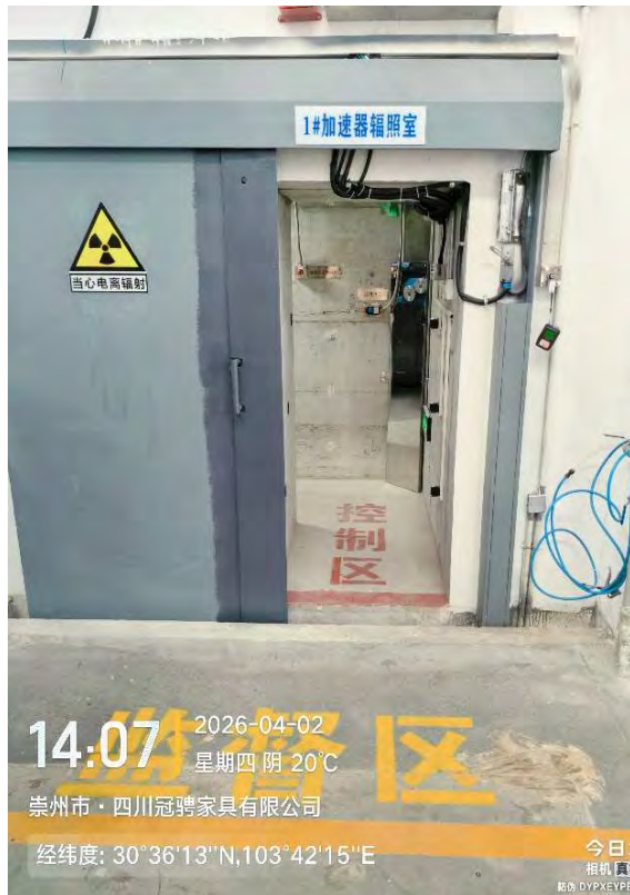
图 3-2-1 本项目 1#工业电子加速器机房辐射防护分区现场照片
