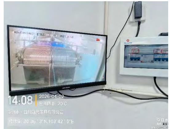
图 3-11-3 本项目工业电子加速器机房摄像监视系统（部分）
