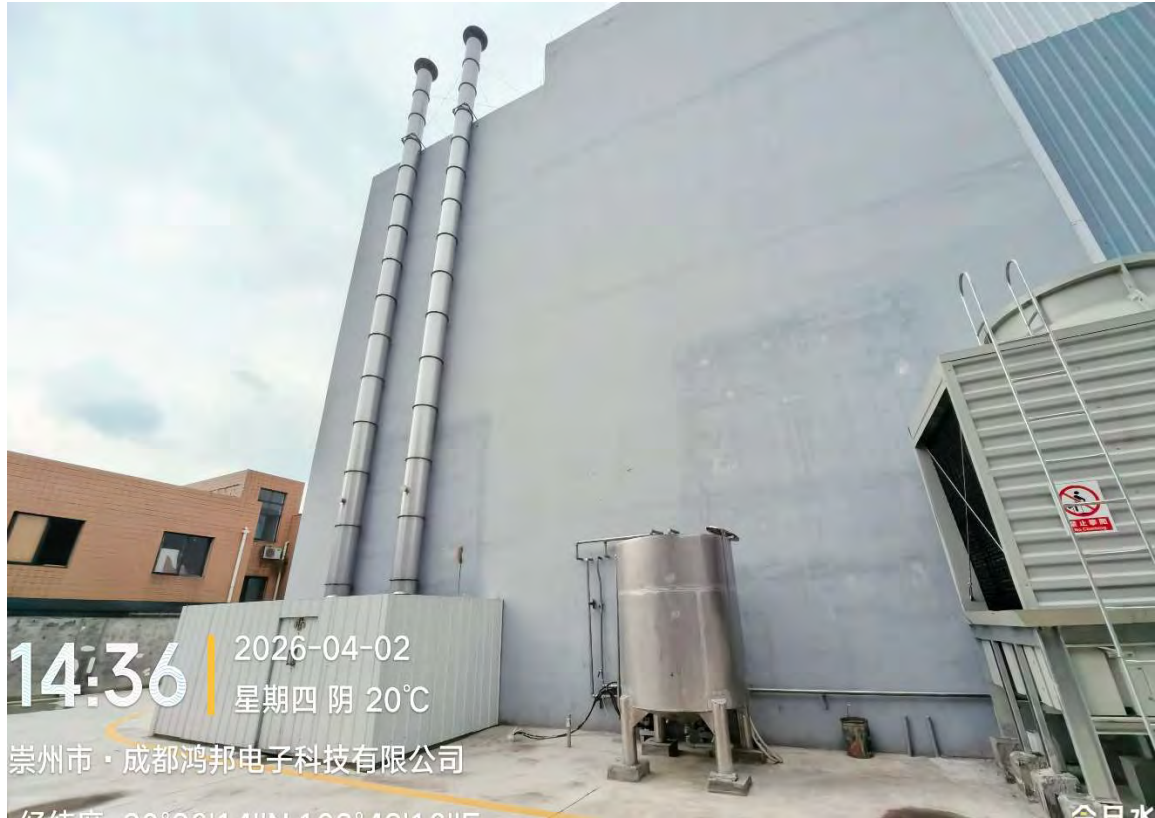
图 3-13-2 本项目工业电子加速器机房排放管道走向
