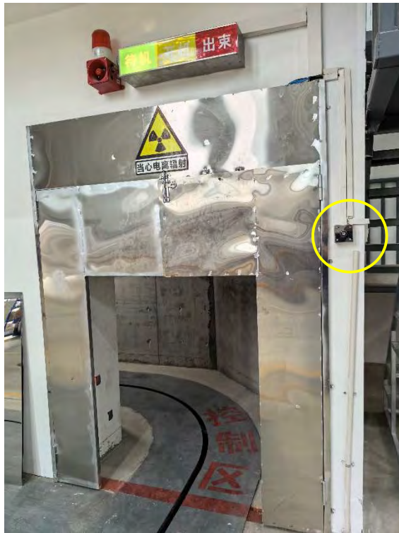
(c) 辐照室防护门钥匙开关 (部分)
