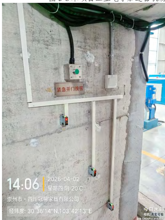
(a) 辐照室光电装置及紧急开门装置（部分）
