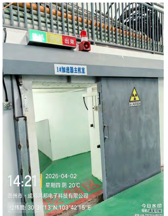
图 3-2-2 本项目 1#工业电子加速器机房辐射防护分区现场照片
