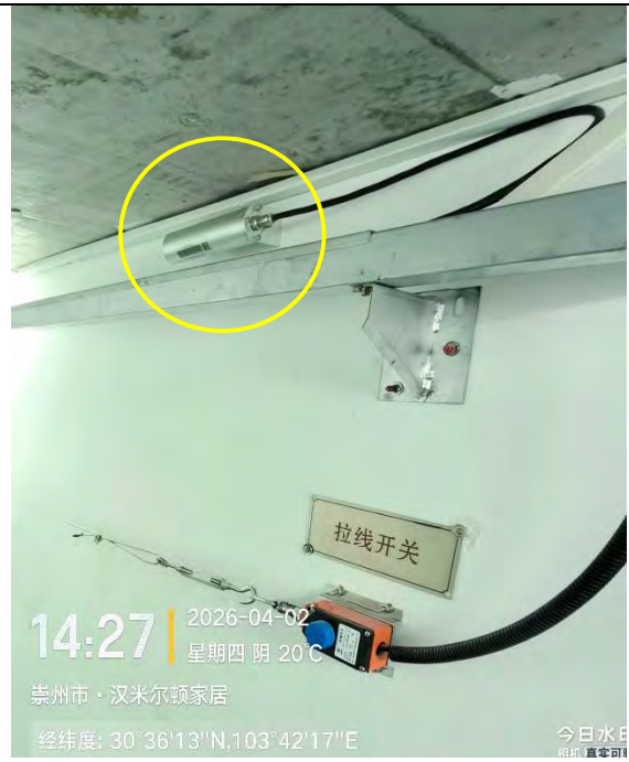
(a) 二层主机迷道内室监测探头
