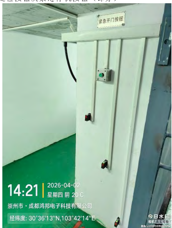
(b) 主机室光电装置及紧急开门按钮（部分）
