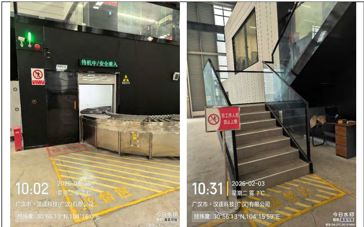
图 3-2-1 本项目工业电子加速器机房辐射防护分区现场照片（一层）
