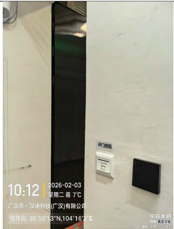
(b) 主机室防护门内侧紧急开门装置
