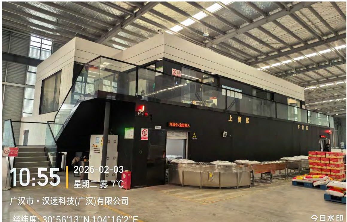
图 2-3 本项目工业电子加速器机房外观图
