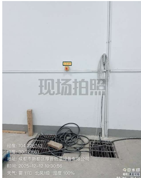
图 3-4 本项目曝光室固定式场所辐射探测报警装置（部分）
