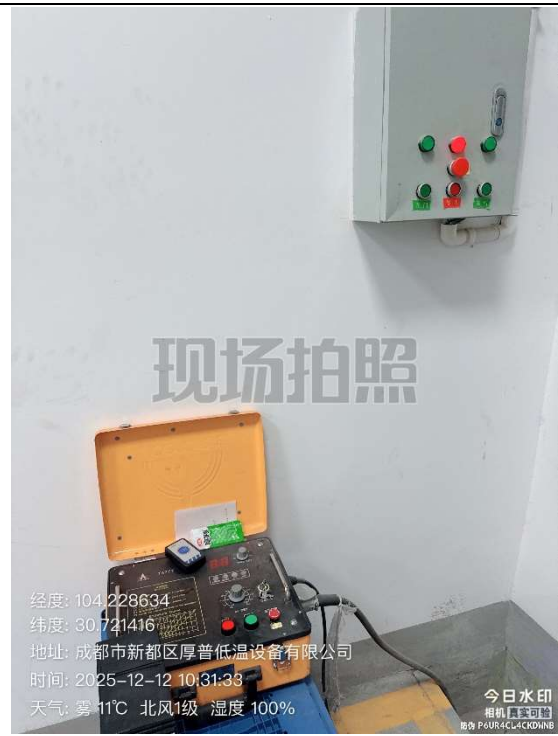
b.紧急停机按钮及设备安全钥匙开关
