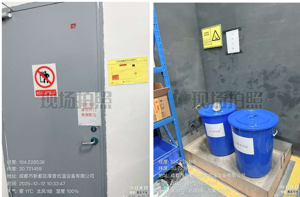
图 3-9 本项目危废暂存间配套设施
