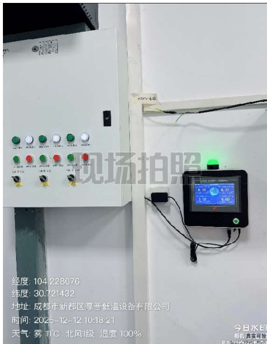
图 3-4 本项目曝光室固定式场所辐射探测报警装置（部分）
