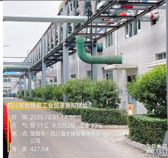
图 8-6 拟建址北侧公用工程车间
