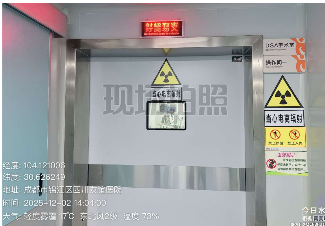
图 3-3 本项目 DSA 手术室当心电离辐射警示标志及工作状态指示灯现场照片
