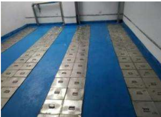
a) 固废间地坑
