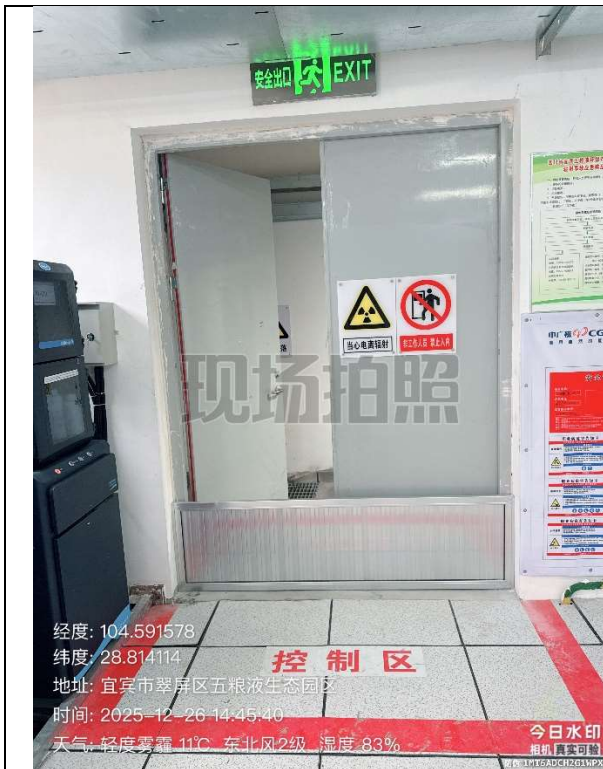
a) 物料/巡检通道入口处
