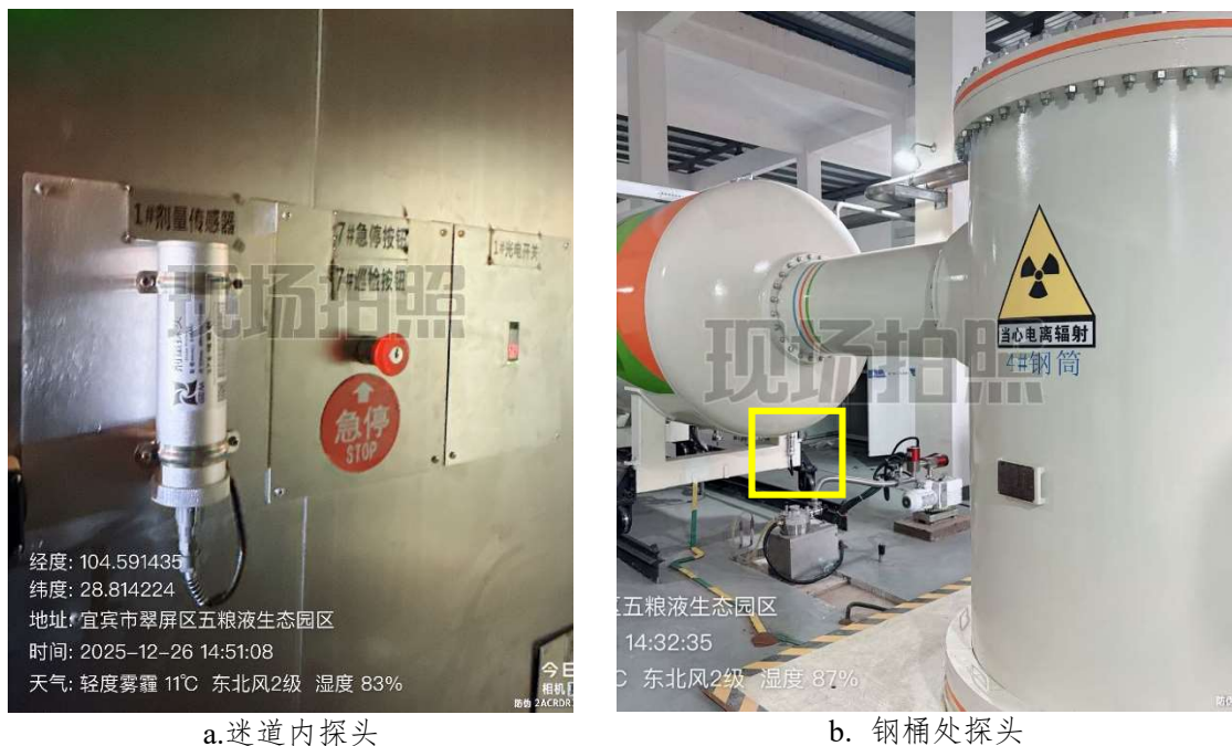
图 3-5-1 固定式实时辐射剂量率监测系统
