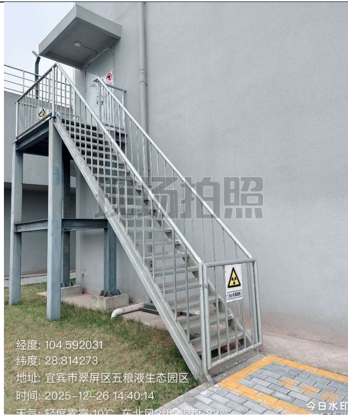
图 3-4 二层设备间的楼梯入口处护栏及当心电离辐射警示标志
