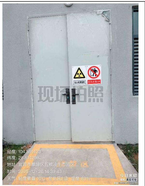
b) 控制室入口处
