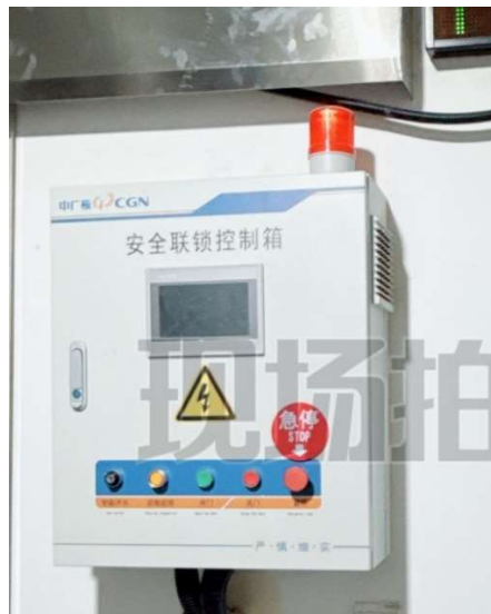
b. 安全联锁控制箱钥匙开关及急停按钮
