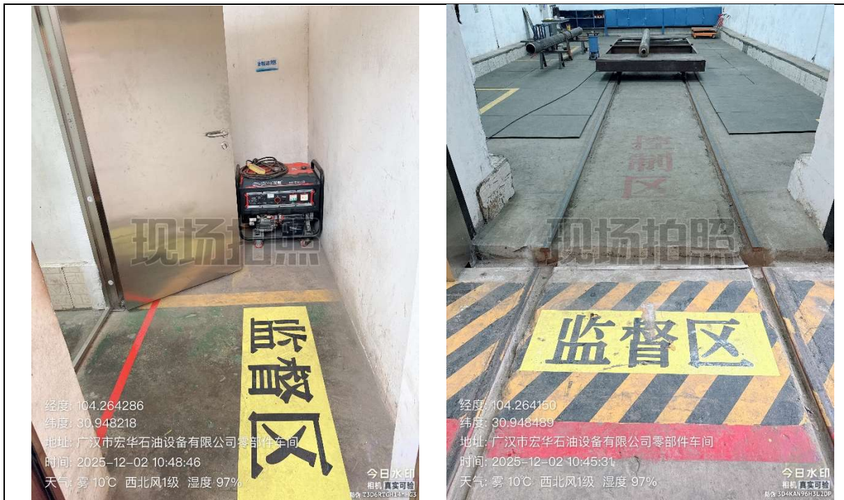
图 3-2 本项目探伤室辐射防护分区现场照片（部分）
